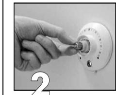
Faites tourner l'axe en laiton et contrôlez la température de l'eau à l'aide d'un thermomètre jusqu'à obtenir une eau à 38°.
