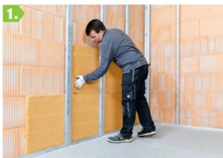
1. Insérer les panneaux isolants entre les montants d'ossature en commençant par le sol jusqu'au plafond. Pour augmenter la performance thermique de la paroi, un isolant peut être disposé contre la paroi avant la mise en œuvre de la paroi.
