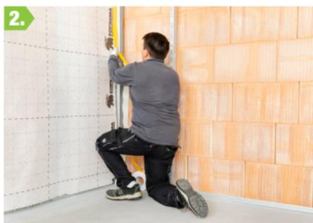
2. Fixer le Pare-vapeur **SOPREMA** en l'agrafant ou en le scotchant à l'aide d'une bande adhésive double-face sur les montants de l'ossature. Respecter impérativement un chevauchement de 100 mm minimum entre chaque lé de pare-vapeur.
