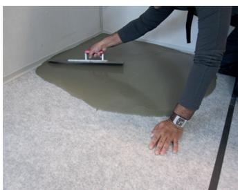
Utiliser les témoins d'épaisseur pour s'assurer d'obtenir au minimum 5 mm de mini chape sur l'ensemble de la surface. Prévoir les dispositifs nécessaires aux arrêts de coulage pour garantir une épaisseur minimale de 5 mm.
