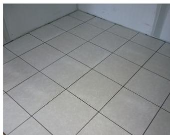
Comblers le joint sous la plinthe avec un mastic élastomère (**Mapesil AC** par exemple). Une circulation piétonne est possible dès 12 heures après le jointoiement, et la remise en service du local peut intervenir 24 heures après le jointoiement.
