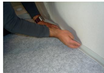
Coller et maroufler la bande de pontage de manière à recouvrir les joints entre les lés.
