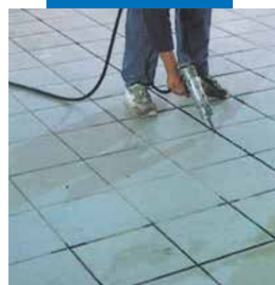
Remplissage des joints de fractionnement
