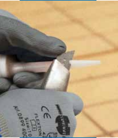
Couper la buse à la dimension souhaitée
