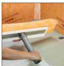
=> 2. Mettre en place le tuyau d'évacuation
