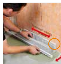
=> 1. Ajuster le support de caniveau
