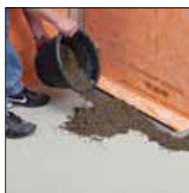
=> 5. Réaliser la chape avec forme de pente
