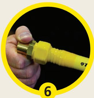
Tester l'installation et protéger la partie dénudée avec de la bande auto-adhésive
