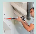
6 / Combler les trous avec du scellement 7 / Mise en place des fixations murales<sup>3</sup> 8 / Vérifiez l'écartement.
