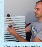
6/Visser les fixations pour ancrage mural bas³. 7/Fixer la goupille⁵ de l'œillet pour verre. 8/Visser les fixations pour ancrage mural 9/Placer les œillets pour verre⁴s en haut<sup>2</sup> et fixer les haubans<sup>1</sup>. veillant au sens des pattes de fixations. pour s'ancrer aux haubans.
