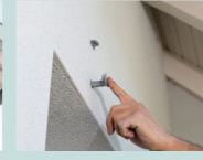
3 / Le diamètre de perçage dépend du 4 / Évacuer la poussière des trous à l'aide 5 / Placer selon la nature du mur, les chevilles tamis ou les tiges filetées.
