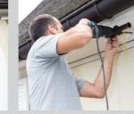
perçage. L'idéal étant de démarrer par les du système de fixation et du type de mur. selon le type de mur, de chevilles tamis. Évacuer la poussière des trous à l'aide d'une pompe à souffler.
