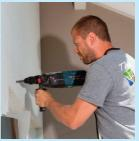
2 / Percer. Le diamètre de perçage dépend 3 / Combler les trous avec du scellement 4 / Placer les tiges filetées. trous de perçage. La précision du traçage (voir infos ci-dessus). Évacuer la poussière villes tamis. des trous à l'aide d'une pompe à souffler.
