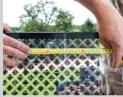
10 / Le trou présent sur la dalle de verre doit être positionné vers le bas. Il servira à bloquer le vitrage au moyen des 2 fixations de sécurité<sup>8</sup>.
