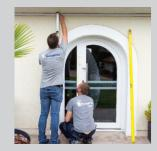
1 / Repérer l'emplacement de fixation du 2 /Placer le profil autoporteur¹ au mur. profil autoporteur centré par rapport à la
