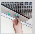
12 / Bloquer le vitrage à l'aide des 2 13 / Glisser le joint de vitrage supérieur<sup>2</sup>. autoporteur. Selon la largeur, une 3º per- fixations de sécurité latérales<sup>8</sup> au moyen sonne peut être nécessaire (le vitrage peut de la clé à ergots et serrer les fixations peser jusqu'à 140 kg).
