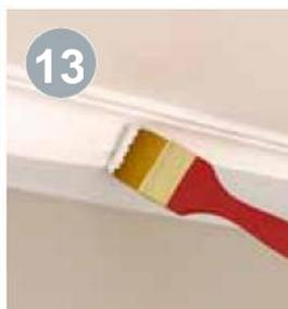
9 Revenez à l'angle de départ : vous pouvez maintenant encoller abondamment la corniche sur les 2 surfaces planes au dos, c.-à-d. là où elle touchera le mur et là où elle touchera le plafond. Assurez-vous que la surface encollée soit propre et sans poussière. Placez la corniche sur la ligne d'appui et faites ressortir l'excès de colle en haut et en bas en exerçant une légère pression. Maintenez-la en place quelques instants.
