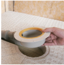
=> 3. Mettre en place le corps du siphon
