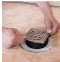
=> 9. Insérer la grille en inox dans l'avaloir et régler la hauteur
