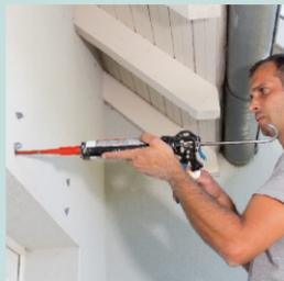
6 / Comblers les trous avec du scellement chimique.
