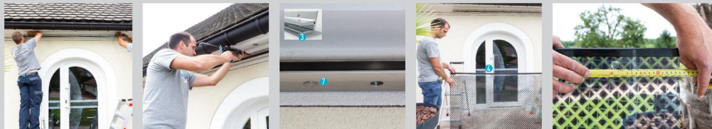
6 / Selon le type de mur, placer les tiges filetées ou fixer le profil au moyen de chevilles adaptées. Laisser reposer selon les préconisations du fabricant.
