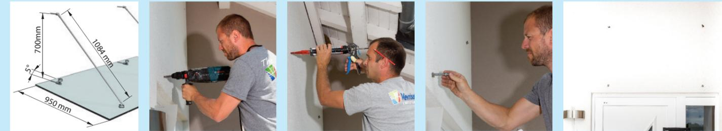
1 / Repérer les cotes de perçage. Vérifier le niveau et marquer au crayon les trous de perçage. La précision du traçage donnera l'inclinaison à la marquise.
