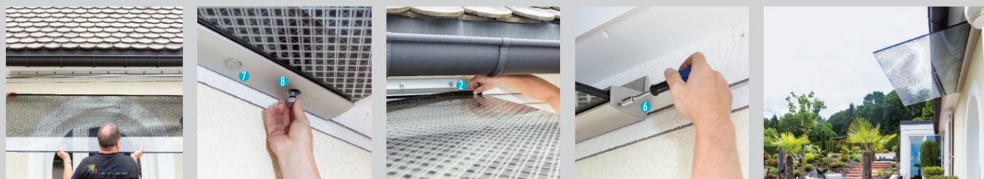
11 / Insérer la dalle de verre dans le profil autoporteur. Selon la largeur, une 3<sup>e</sup> personne peut être nécessaire (le vitrage peut peser jusqu'à 140 kg).
