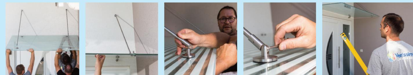
11 / Placer la dalle de verre sur les supports arrière. Selon la largeur, une 3<sup>e</sup> personne peut être nécessaire (le vitrage peut peser jusqu'à 140 kg).
