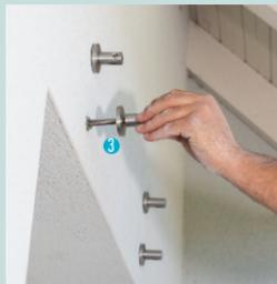
7 / Mise en place des fixations murales<sup>3</sup> (tiges filetées et œillet pour console).
