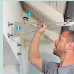
9 / Fixer les consoles<sup>1</sup> au mur et les supports pour verre<sup>2</sup> à la console.
