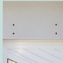
3 / Le diamètre de perçage dépend du système de fixation et du type de mur.
