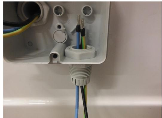
Kabel in korrekter Reihenfolge anschließen .
