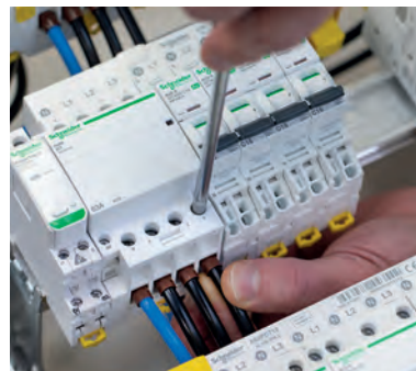
▲ Système contacteur tête de groupe supprimant une boucle de câblage.
