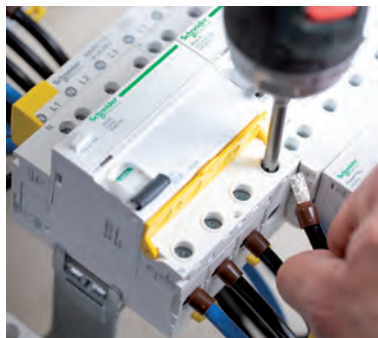
▲ Interrupteur différentiel à alimentation par le bas autorisant un raccordement direct par peigne aux départs.
