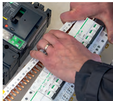
▲ Raccordement automatique en amont.
