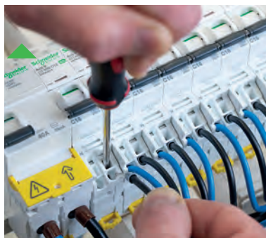
▲ Connexions automatiques compatibles aussi avec des câbles souples avec embouts.
